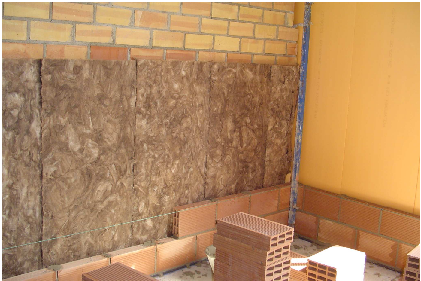
Pared separadora tipo 2B – Panal 11,5+Super 6,5
